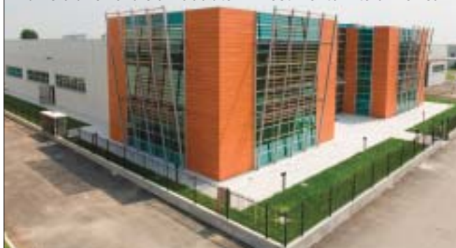
Edificio direzionale a Robbiate - Rivestimento Piterak Terreal
