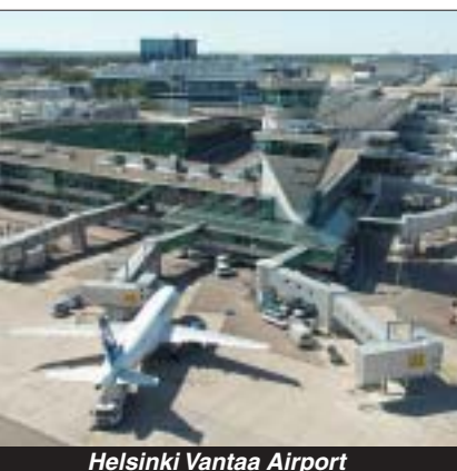
Helsinki Vantaa Airport
